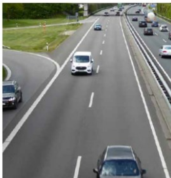
Ausbau der A 23
